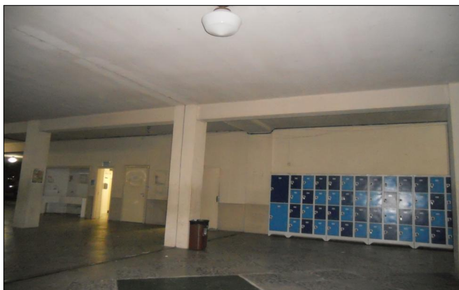
Fig. 27. Falta de iluminação em uma parte do Pátio da Ala par. Fonte: Acervo do autor, 2013.
