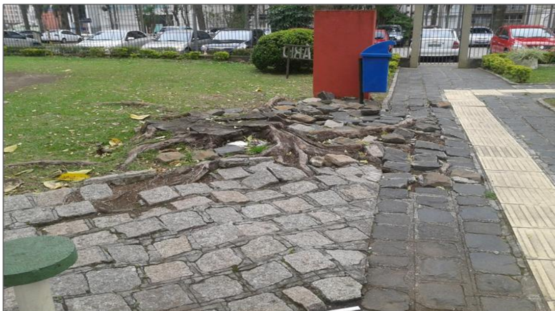
Fig. 21. Pedras soltas em frente ao Planetário. Fonte: Acervo do autor, 2013.
